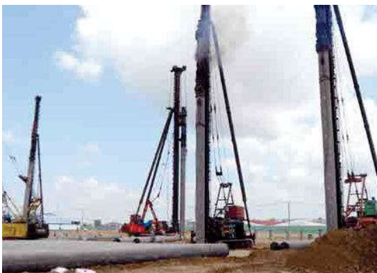
Thiết bị đóng cọc / Pilling rig Quatity: 06 units Capacity: 3.5T - 7.2T
